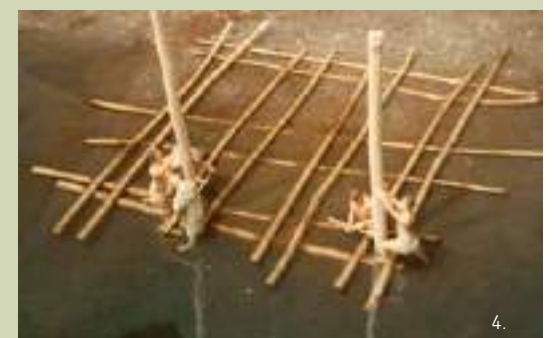
Fasi di impianto del palo: 1. Abbattimento e sramatura del fusto 2. Scortecciatura del tronco 3. Lavorazione del palo o eventuale creazione delle tavole 4. Impianto del palo
